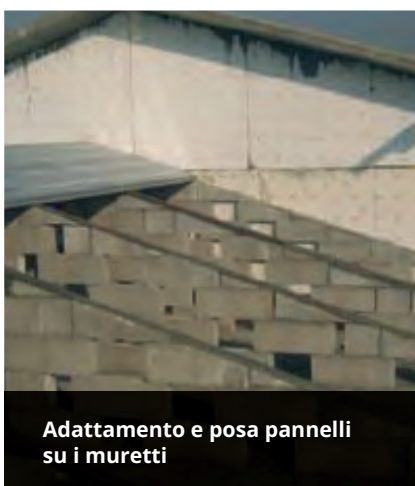
Sistemazione prima di ricevere la rete di ripartizione
