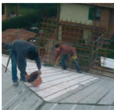
Sistemazione prima di ricevere la rete di ripartizione
