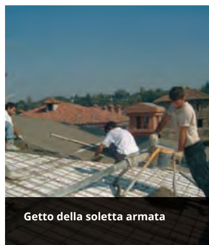
Sistemazione prima di ricevere la rete di ripartizione
