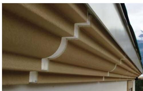
De petits cadres tels que des contours, des fenêtres ou des corniches droites et ayant une section dont les dimensions hors tout maximales sont contenues dans un rectangle de 120x300 mm, peuvent être traités au mortier de ciment au moyen d'un revêtement par extrusion d'une épaisseur moyenne de 3 mm. Ce procédé donne au produit une surface lisse et parfaitement régulière dans la section.
