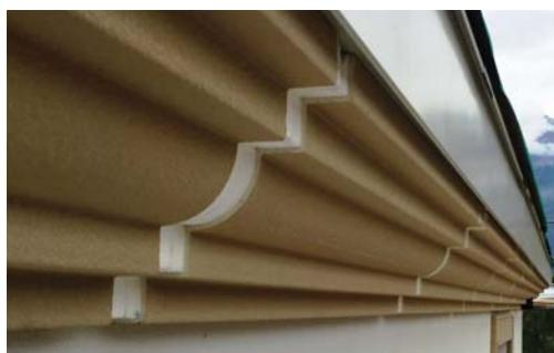
Kleinere Einfassungen, wie Konturen, Fenster oder Gurtgesimse mit geradlinigem Verlauf, deren Abschnitt maximale Außenabmessungen hat, die in ein Rechteck von 120 x 300 mm passen, können mit Zementmörtel mittels Extrudierbeschichtung mit einer durchschnittlichen Dicke von 3 mm beschichtet werden. Dieses Beschichtungsverfahren verleiht dem Produkt eine glatte und vollkommen regelmäßige Oberfläche in dem Abschnitt.
