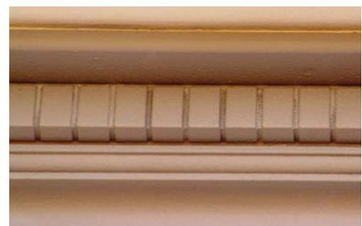
Bei größeren oder unregelmäßigen oder krummlinigen Fertigerzeugnissen oder bei speziellen dreidimensionalen Formteilen wird das Zementspritzverfahren für eine Dicke von ca. 2 mm angewendet. Auf diese Weise wird das Finish leicht rau.
