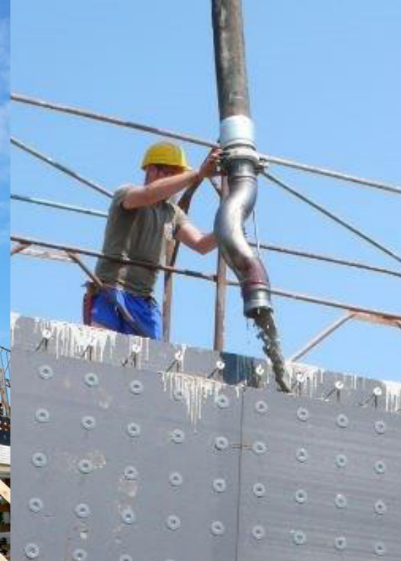
Odlievanie betónu s betónové čerpadlo
