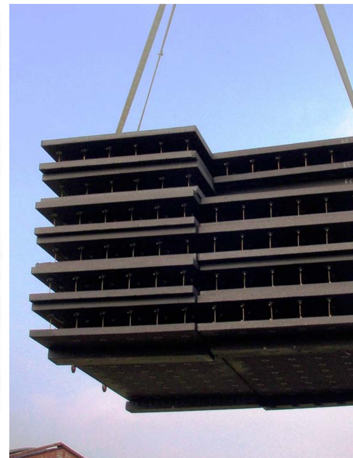
Manipulácia panelov so žeriavom
