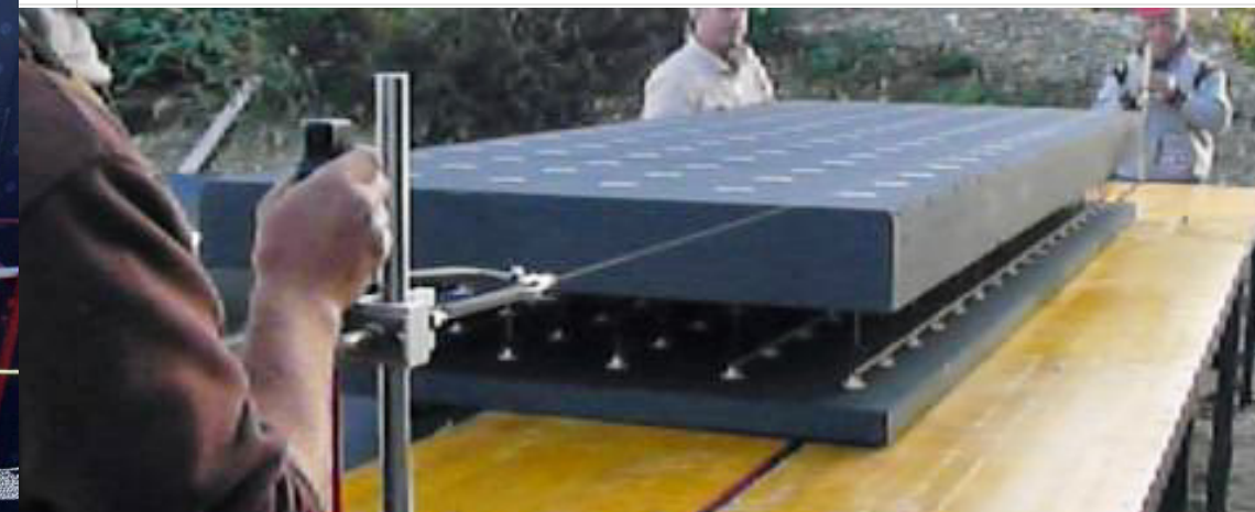
Rezanie debniaceho panelu na stavenisku
