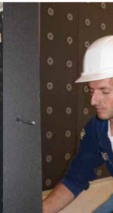
Montáž EPS doska na uzavretie tepelného mosta na čelo panelov
