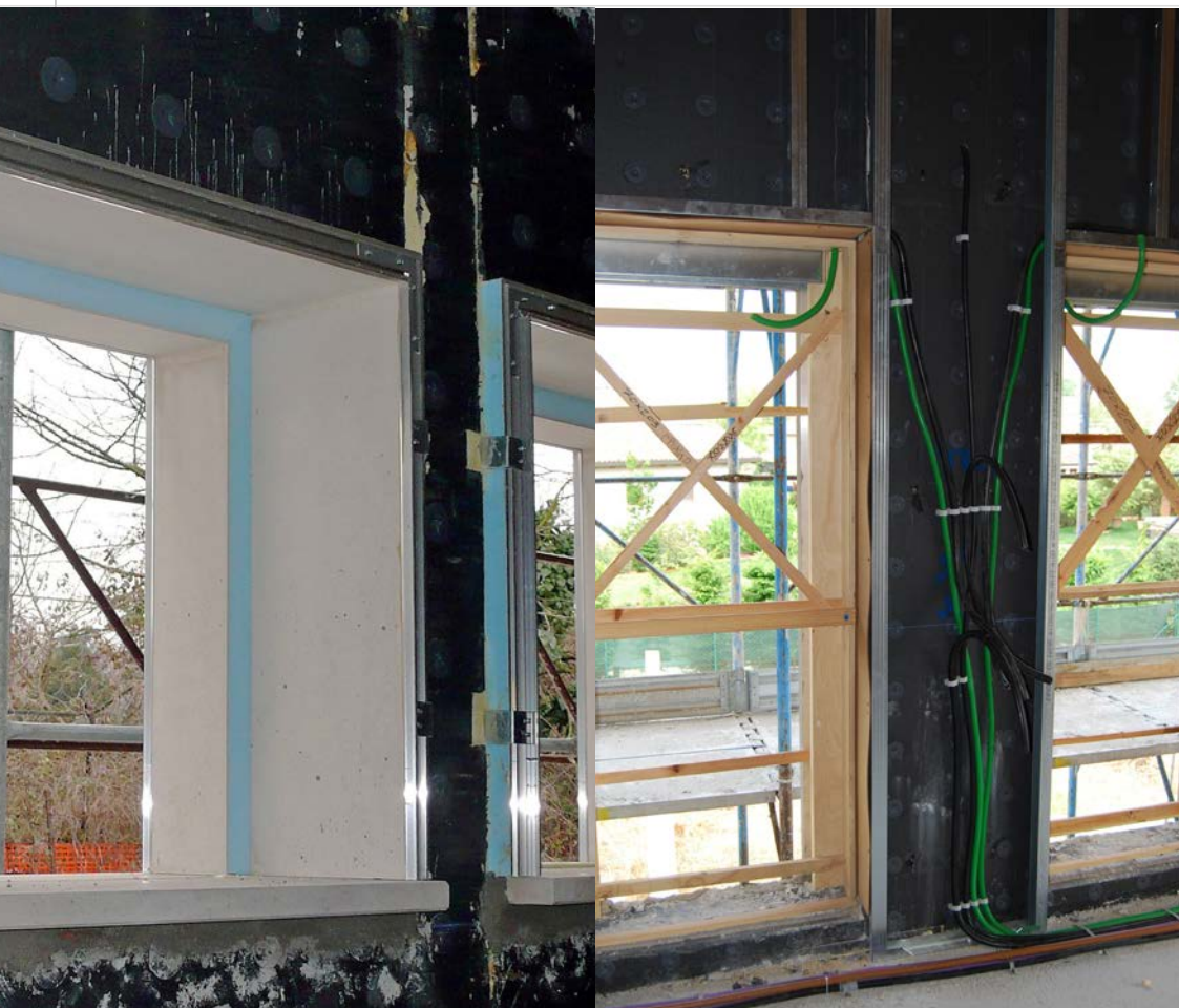
Prefabrikované rámy okien a dverí, ktoré sa majú vložiť pred odlievaním
