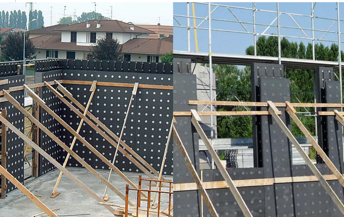
Panely umiestnené vedľa seba a držané rovno s diagonálnymi vzperami, upevnené na drevenej doske umiestnenej vodorovne a pribitá v hornej časti panelov.
