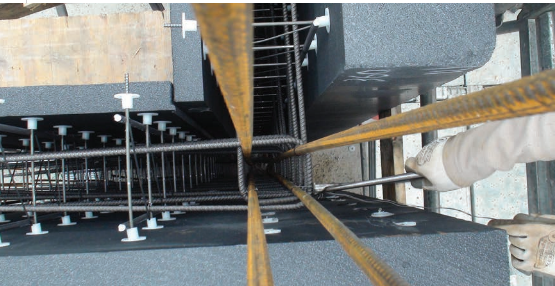
Nod de colț, semi-deschis / propunere de armare
