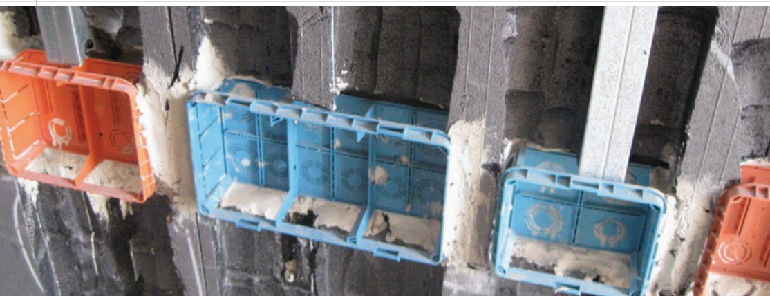
Instalații, conducte așezate pe panoul Zid Plastbau® 3
