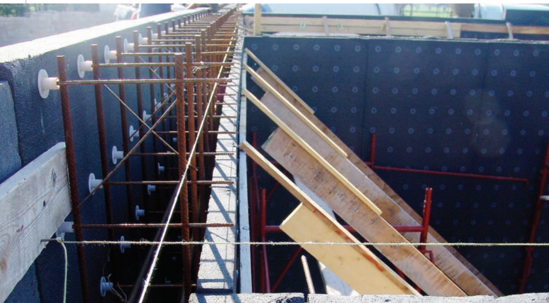
Detaliu al nervurii pentru rețeaua de podea
