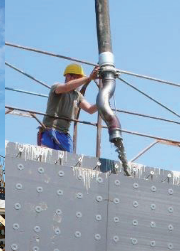
Turnarea cu pompa
