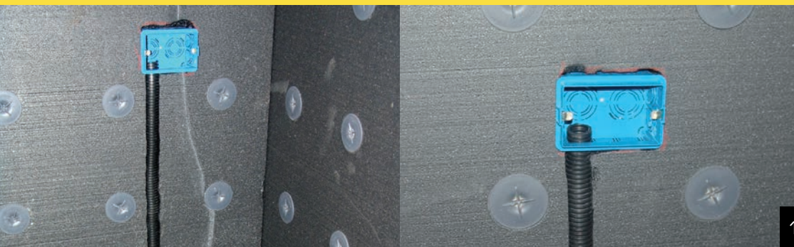
Instalações e condutas no painel interno da Parede Plastbau® 3
