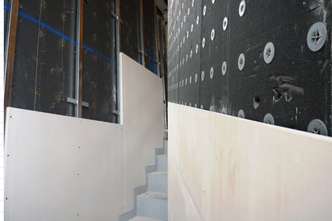
Placa de estuque montada numa estrutura
