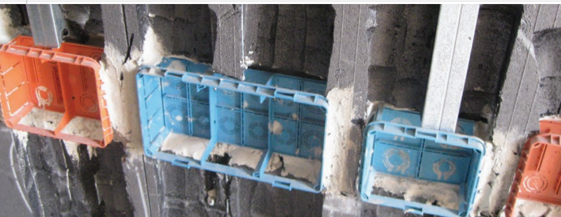
Instalações e condutas no painel interno da Parede Plastbau® 3
