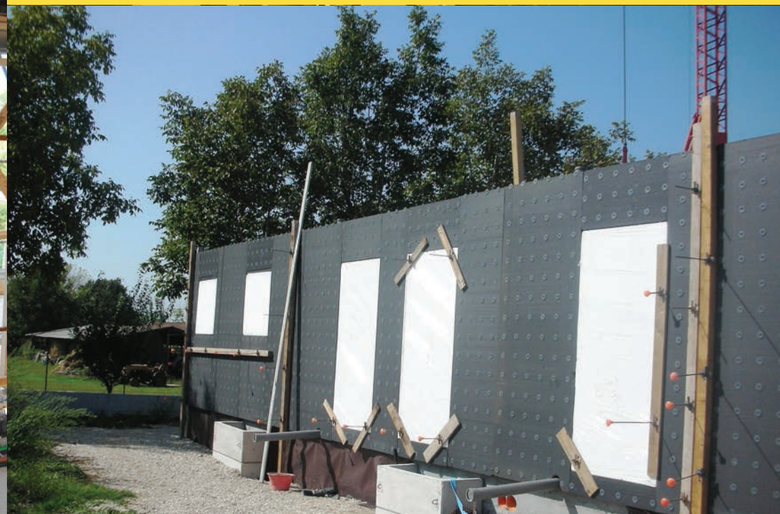
Fixage des coffrages avec des blocs en EPS à mesure
