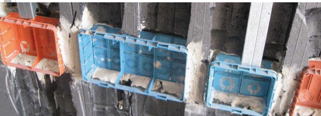
Installations, conduites, cheminées dans le panneau interne Wall Plastbau® 3
