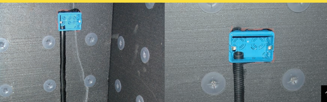
Installations, conduites, cheminées dans le panneau interne Wall Plastbau® 3
