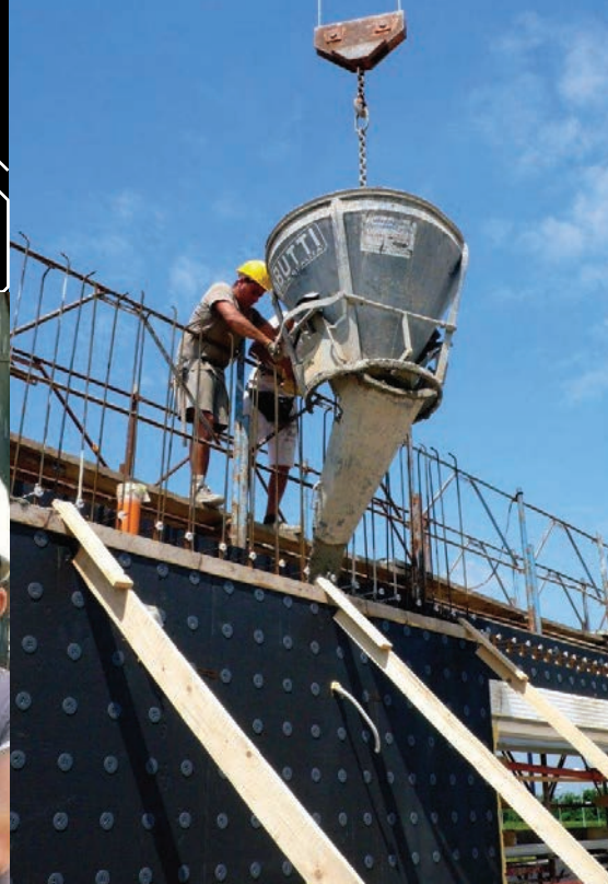
Coulage avec un benne
