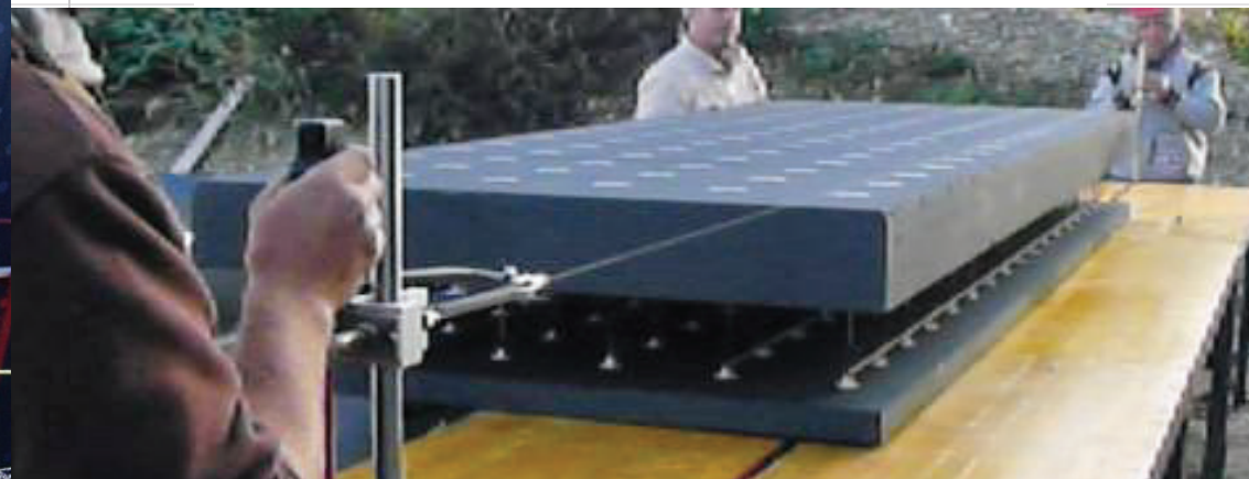
Corte de los paneles de encofrado in situ - los paneles se pueden cortar también usando una sierra manual
