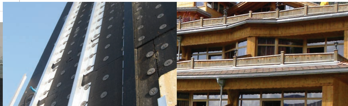
Revestimiento en seco, fijado mecánicamente
