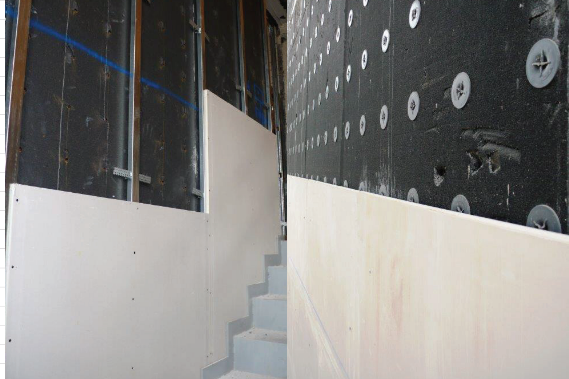
Cartón yeso montado en una estructura
