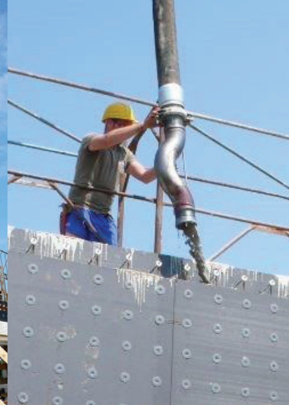
Betonguss mit Pumpe
