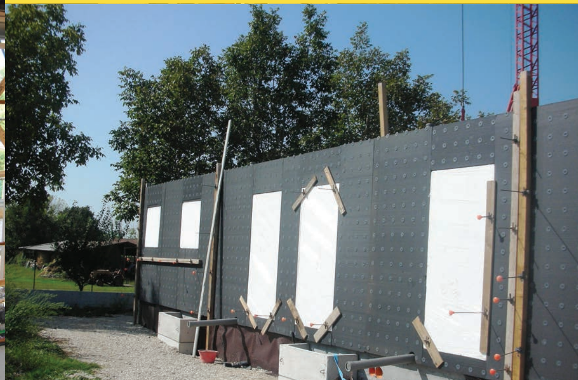
Montage von Schalungen mit maßgefertigten EPS-Blöcken
