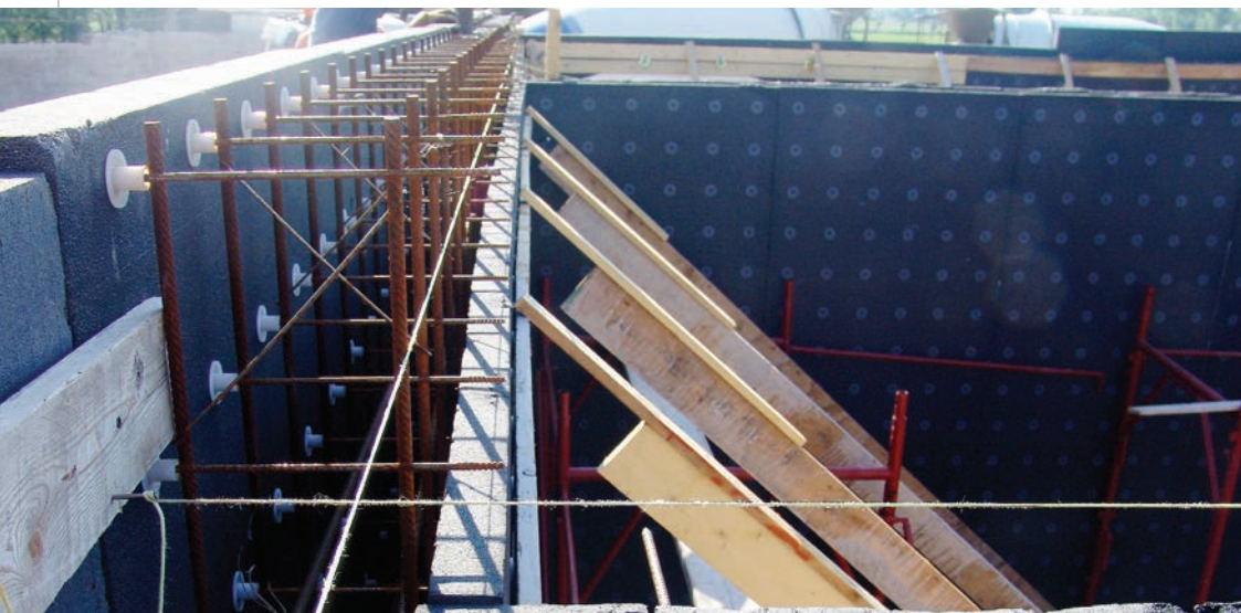
Detailansicht der Rippe des Bodengitters
