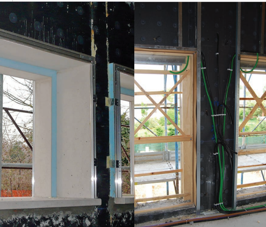
Vorgefertigter Rohbaurahmen, der vor dem Betonguss montiert wird
