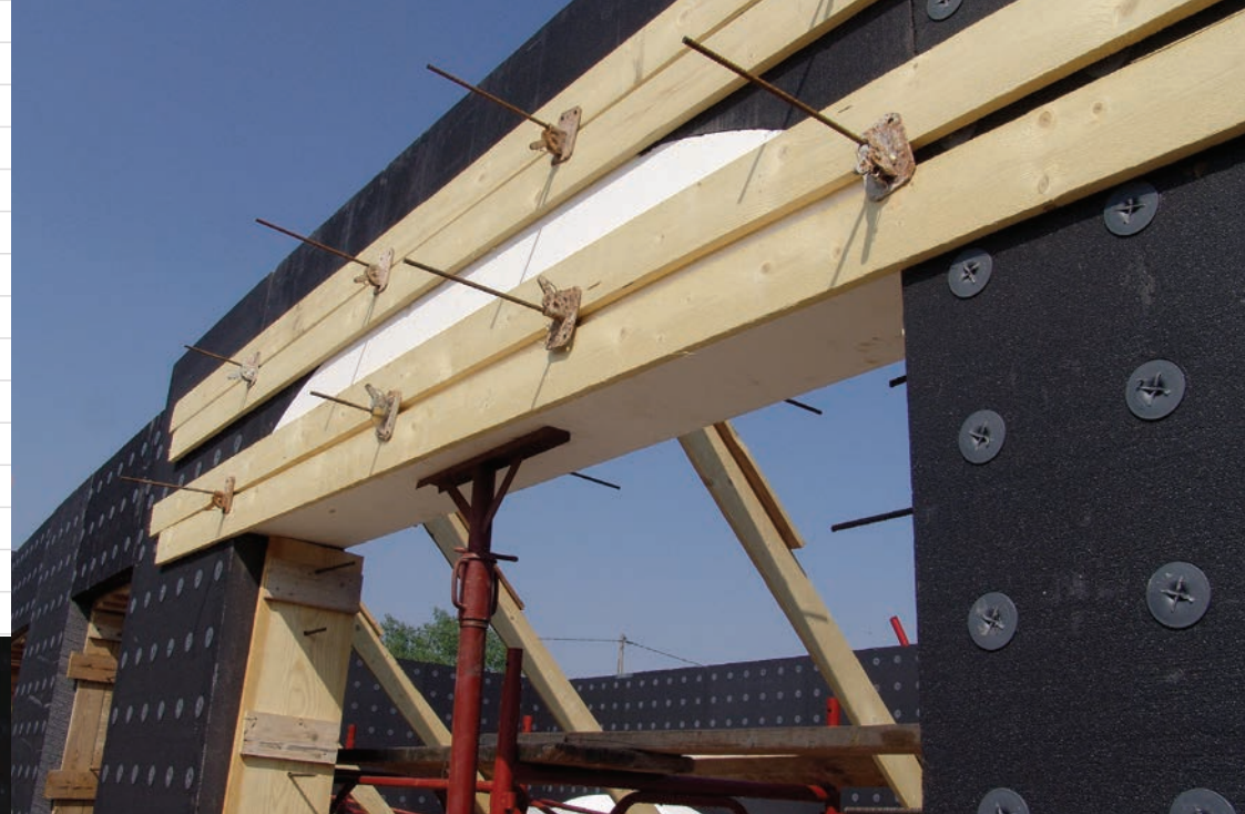
Montage von Schalungen an gewölbten Architraven
