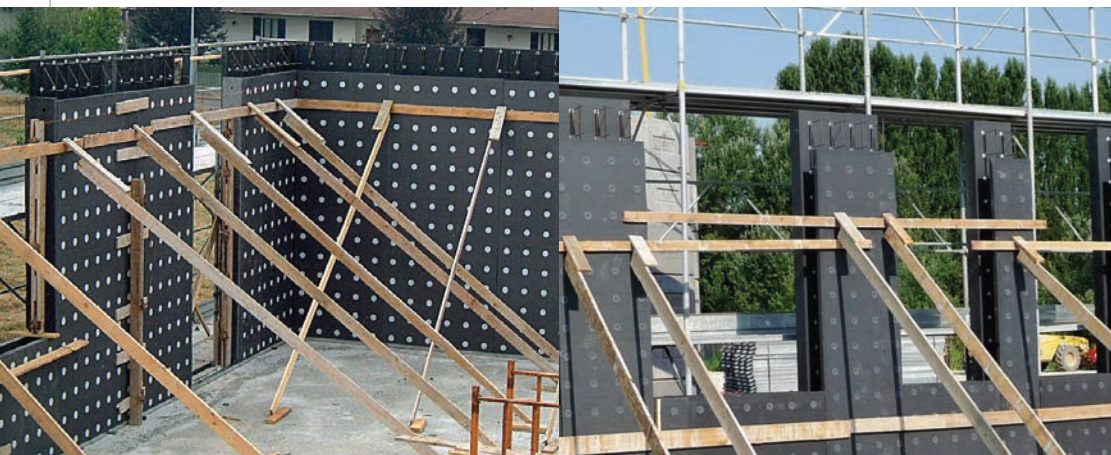
Wandelemente Plastbau® 3 dicht nebeneinander und lotrecht mittels diagonalen Streben, die durch ein durchgehendes Band verbunden sind -auf die Platte genagelt; Dübel PB3
