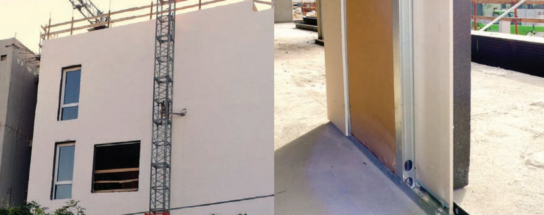
Acabamento externo com polimento isolante
