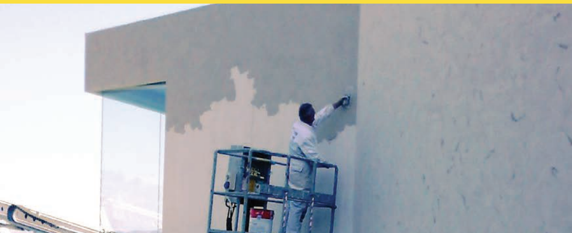
Acabamento com polimento isolante
