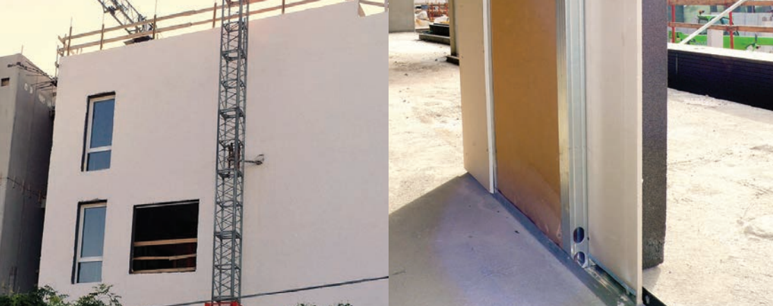
Finisaj exterior și cu izolați
