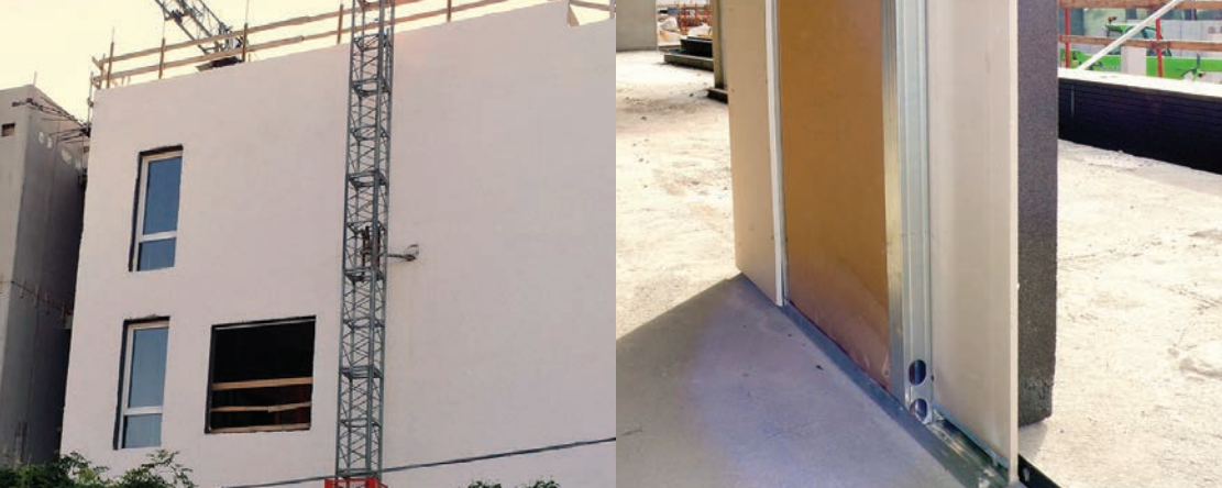
Alisado de aislamiento térmico exterior
