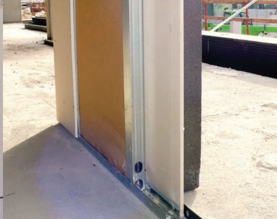
Interne Gegenwand aus Gipskartonplatten mit Steinwolle
