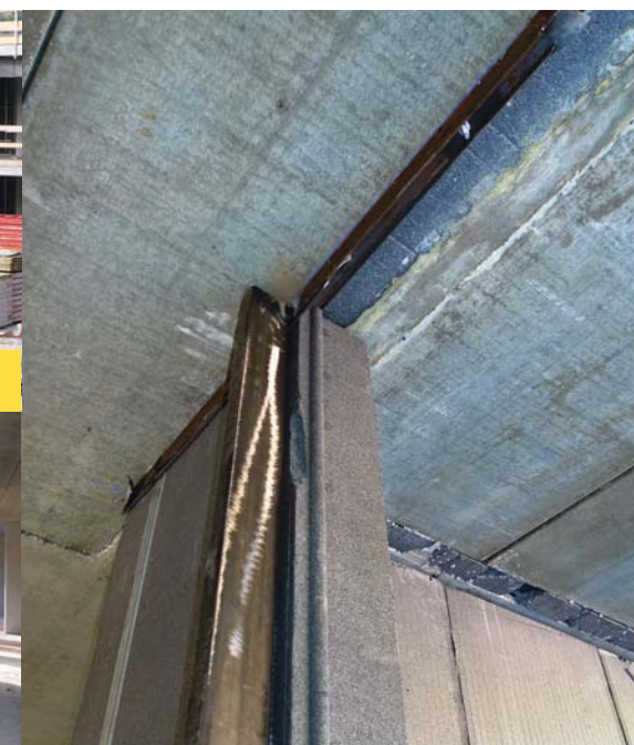
Particolare del telaio per gli infissi
