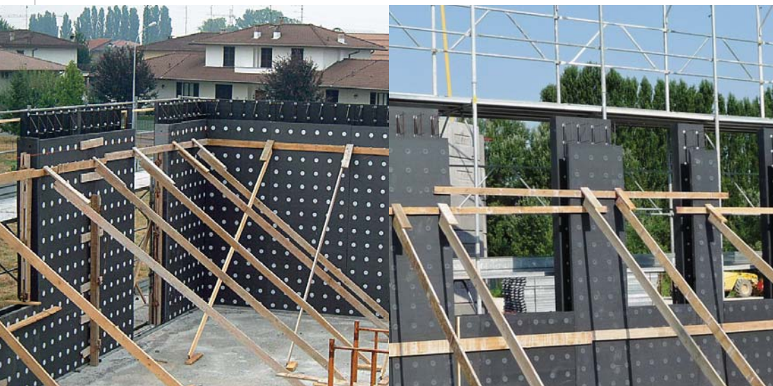
Pannelli accostati messi a piombo tramite puntelli diagonali uniti da una fascia continua inchiodata sui tappi del pannello.
