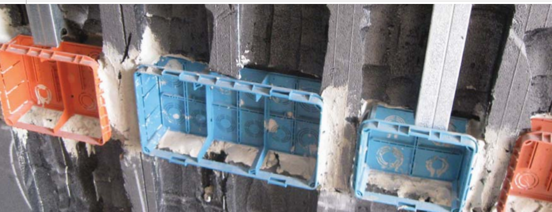
Impiantistica tracce sul pannello interno del muro
