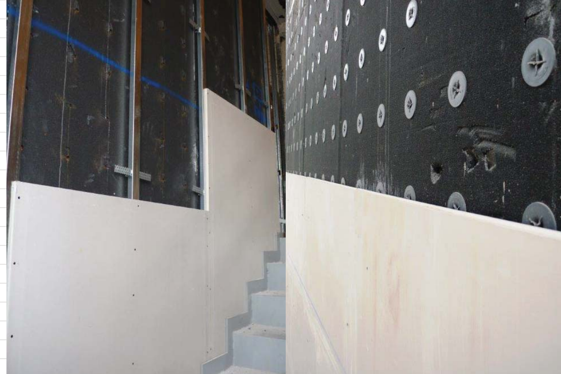
Cartongesso montato su struttura
