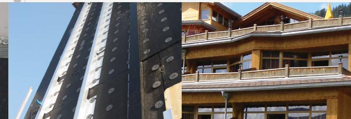
Facciate a secco avvitate meccanicamente
