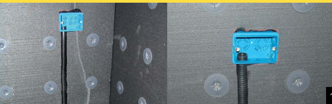
Impiantistica tracce sul pannello interno del muro
