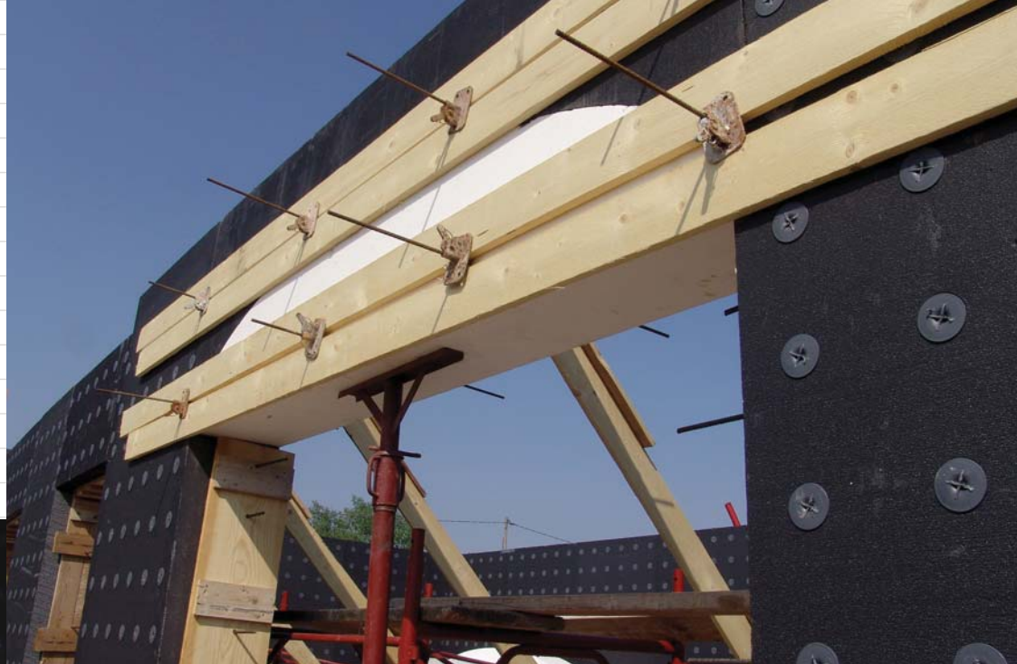
Casseri architravi a volto
