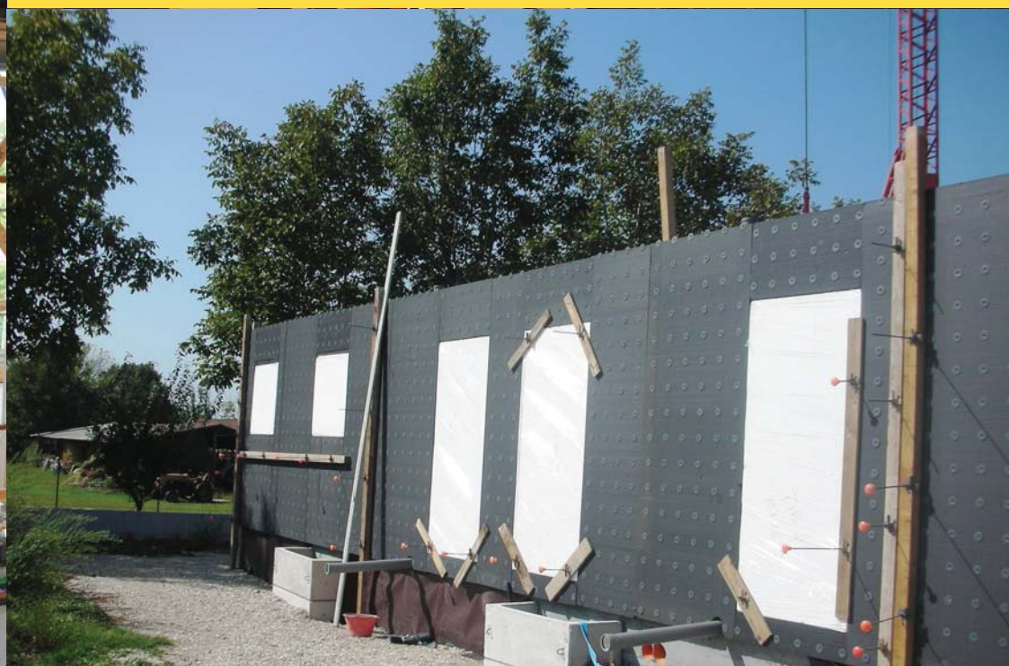
Casseri con blocchi a misura in EPS
