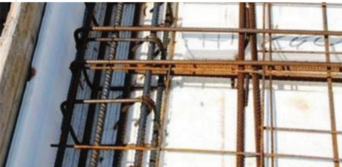
Detail pokládky balkóna
