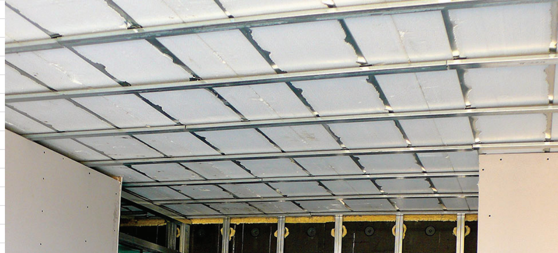
Moldura secundária para aparafusamento de chapas
