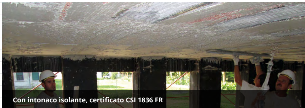
CONTROSOFFITTO SU STRUTTURA METALLICA CON PRESTAZIONI REI
