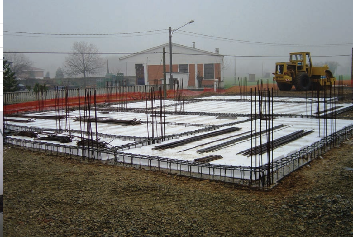
Isolierte Zwischendecke
