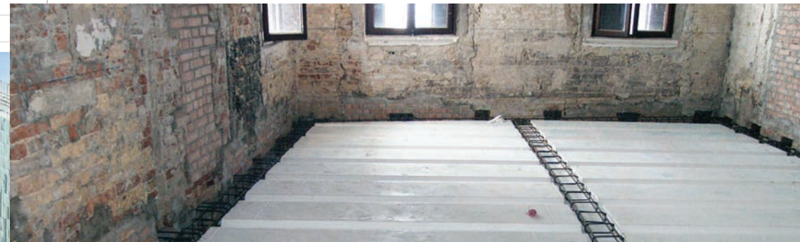
Venedig – Plattensanierung
