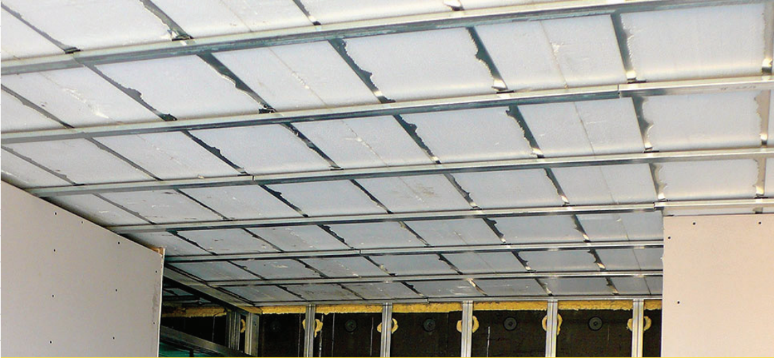
Contramarco para el enroscado de placas
