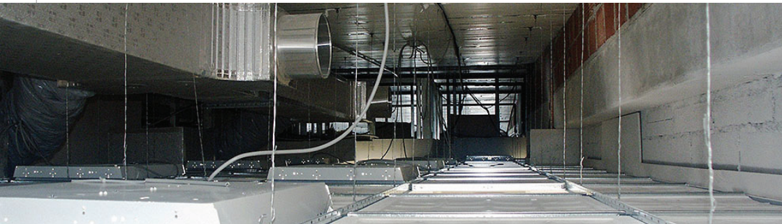
Falso techo rebajado y suspendido
