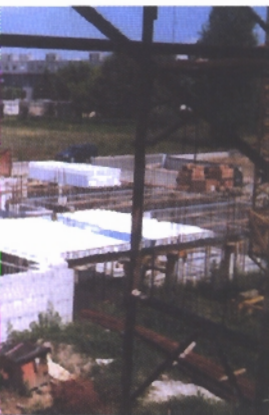
Pannello in polistirene autoportante, grazie agli inserti a Z in lamiera zincata, per la realizzazione di solai. Grazie alla sua leggerezza, la movimentazione degli elementi è estremamente agevole (Poliespanso).
