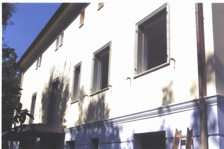
Facciata finita con marcapiano e cornici
