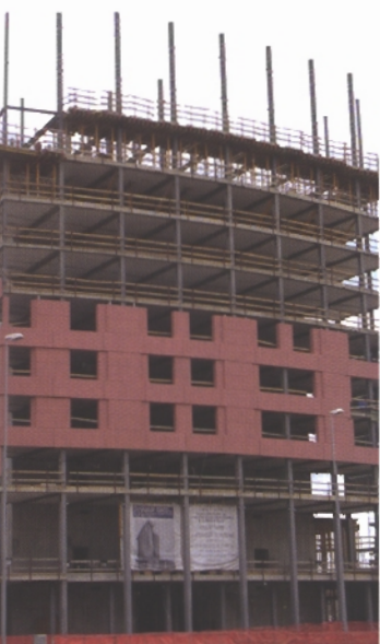
Il cantiere dell'Hotel Hilton
