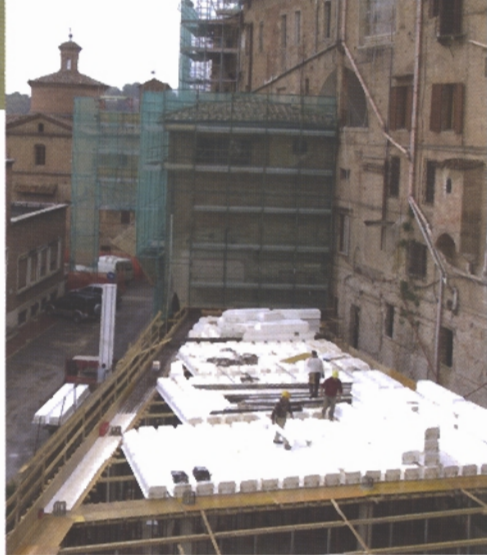
Recupero complesso Santa Maria della Scala a Siena.
