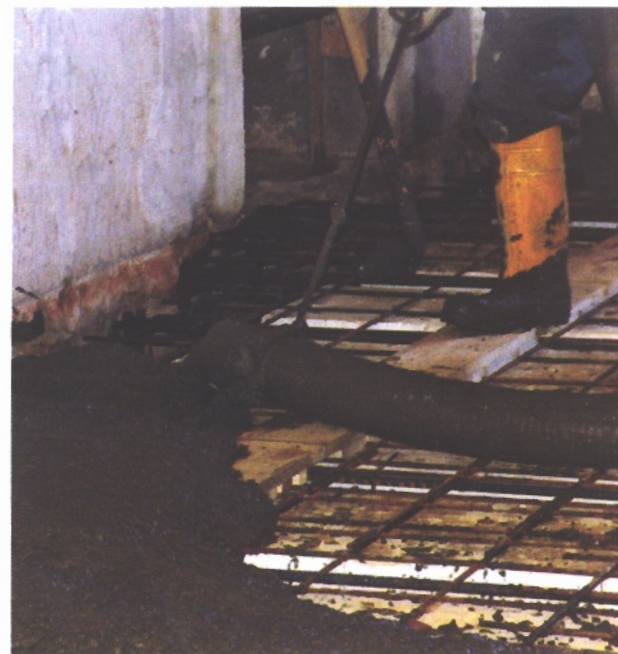
Alcune fasi dell'intervento di ristrutturazione delle due sale espositive del primo piano dell'ala sud a ponente con solaio Plastbau Metal
