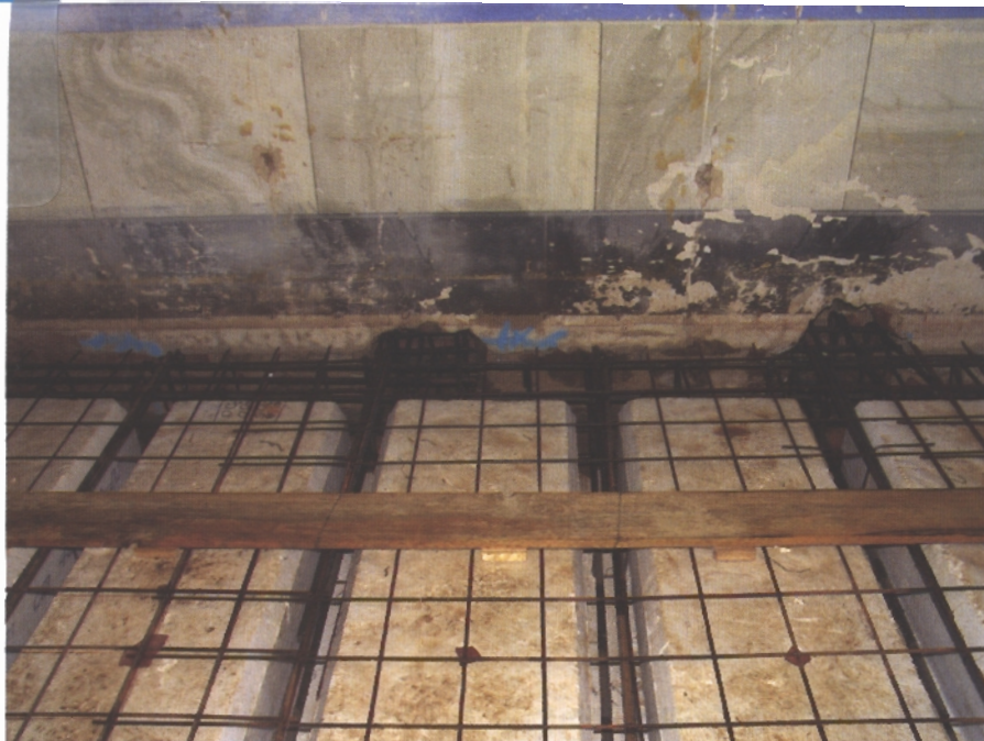
Alcune fasi dell'intervento di ristrutturazione delle due sale espositive del primo piano dell'ala sud a ponente con solaio Plastbau Metal
