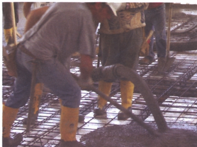
Getto del solaio
