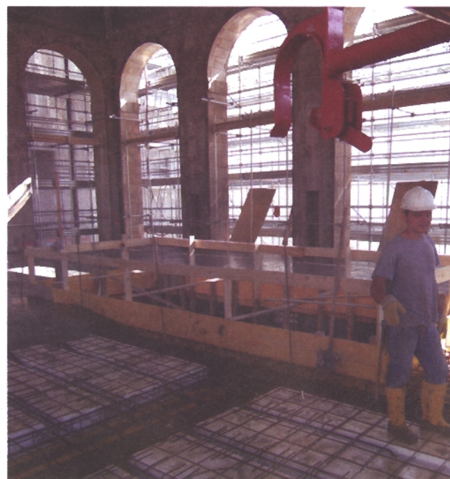
Ristrutturazione dell'Arengario: getto del solaio Pbm
