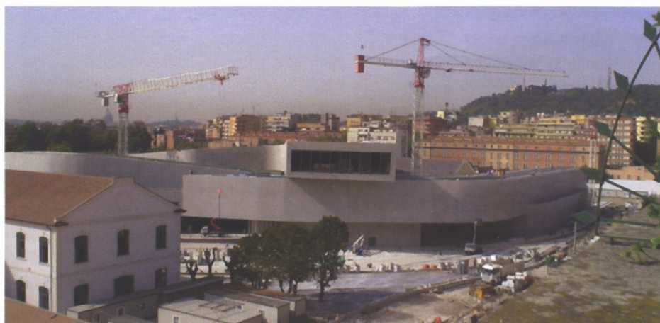
Vista generale sul cantiere del Maxxi a Roma (© Helen Binet)
