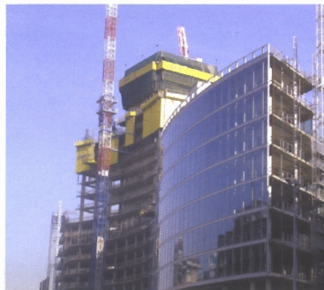
Cantiere del progetto della nuova sede della Regione Lazio
