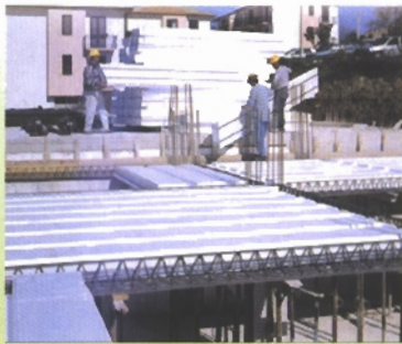
Nella foto a lato: Esempio di posa di solaio in polistirolo espanso autoportante (Poliespanso).
